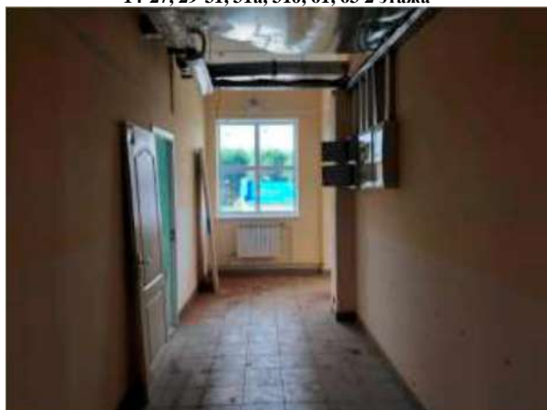
Помещение, назначение: нежилое, площадь 2425,9 кв.м., поз. 47, 50, 52, 53 1 этажа
