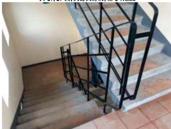
Помещение, назначение: нежилое, площадь 2425,9 кв.м., поз. 47, 50, 52, 53 1 этажа
