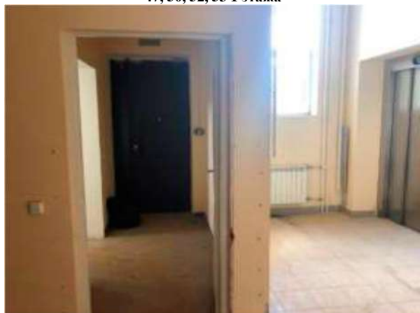
Помещение, назначение: нежилое, площадь 2425,9 кв.м., поз. 47, 50, 52, 53 1 этажа
