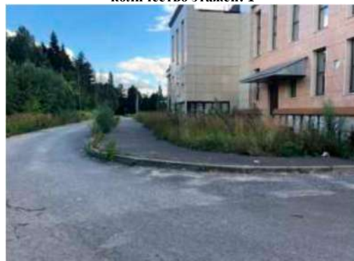
Часть автостоянки на 225 машиномест (Автостоянка на 120 машиномест), назначение: нежилое, площадь 5440 кв.м, количество этажей: 1
