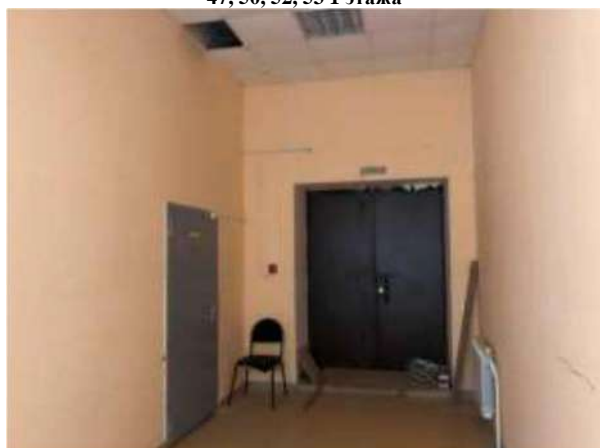
Помещение, назначение: нежилое, площадь 2425,9 кв.м., поз. 47, 50, 52, 53 1 этажа
